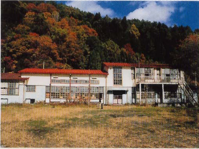
改修工事の進む「もりの学校」
